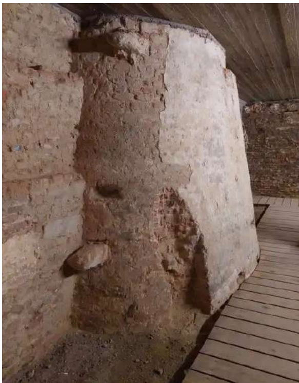
↑ FUNDAMENT VAN DE HUIDIGE KERK
